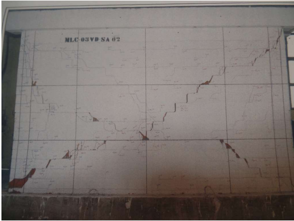
Figura 0.15. Muro 41, MLC-03VD-SA02 (Sierra, 2002).
