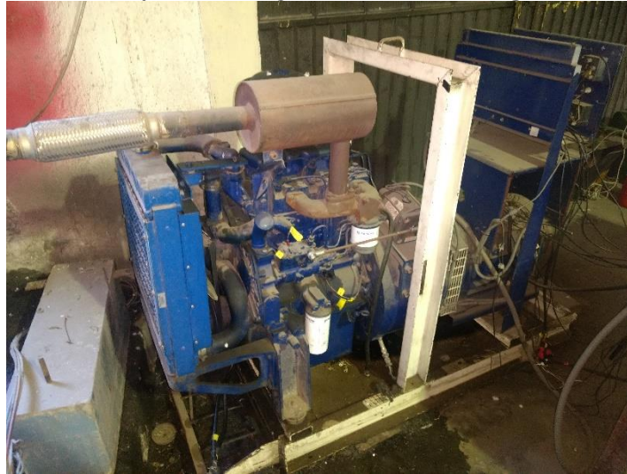
Figura 21: Grupo electrógeno 20 kVA.
