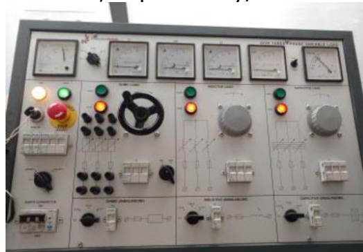
Figura 28: Carga trifásica resistiva, inductiva y capacitiva.
