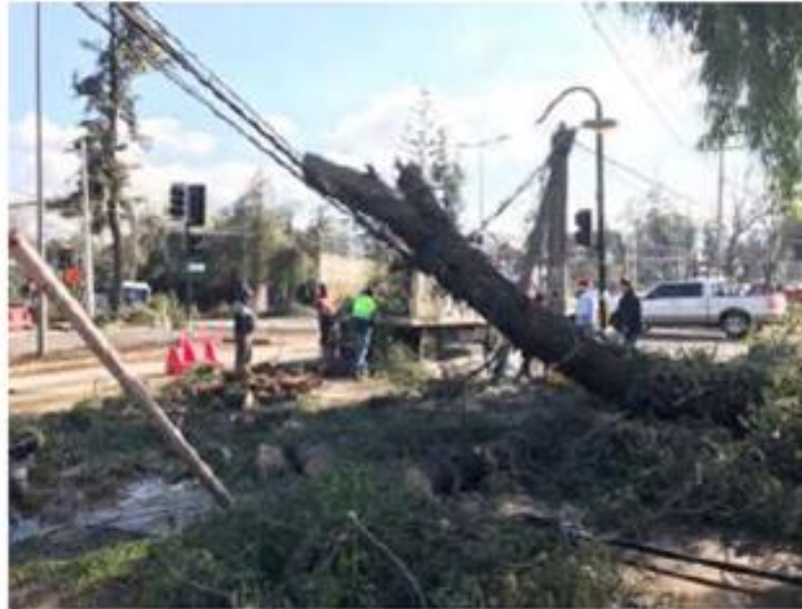
Figura 2-2: Corte de líneas por árboles caídos tras la nevada en Santiago, 2017 [9].
