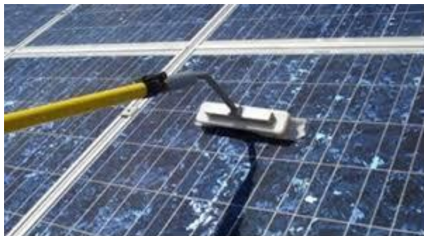
Imagen 2. Limpieza de paneles solares. [15]
