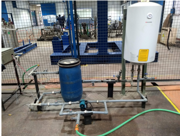
Figura 4.19: Instalación banco de pruebas
