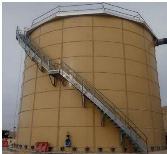
ILUSTRACIÓN N° 5 IMAGEN REFERENCIAL ESTANQUE APERNADO
