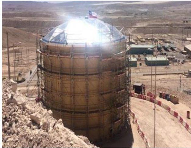
ILUSTRACIÓN N° 4 IMAGEN REFERENCIAL ESTANQUE APERNADO
