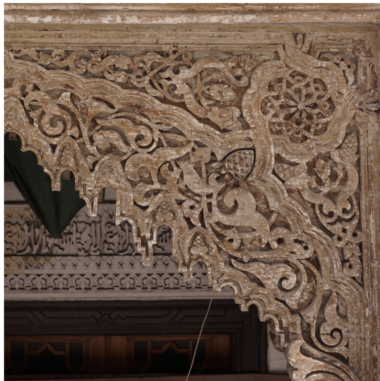
Sección ornamental de fachada principal.
