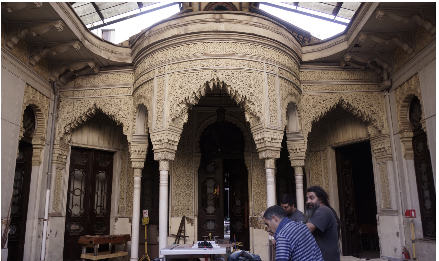
Fachada norte Patio Los Leones Fuente: Archivo CREA y ©Project
