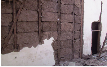
Muro de adobe, Palacio Alhambra Santiago.
