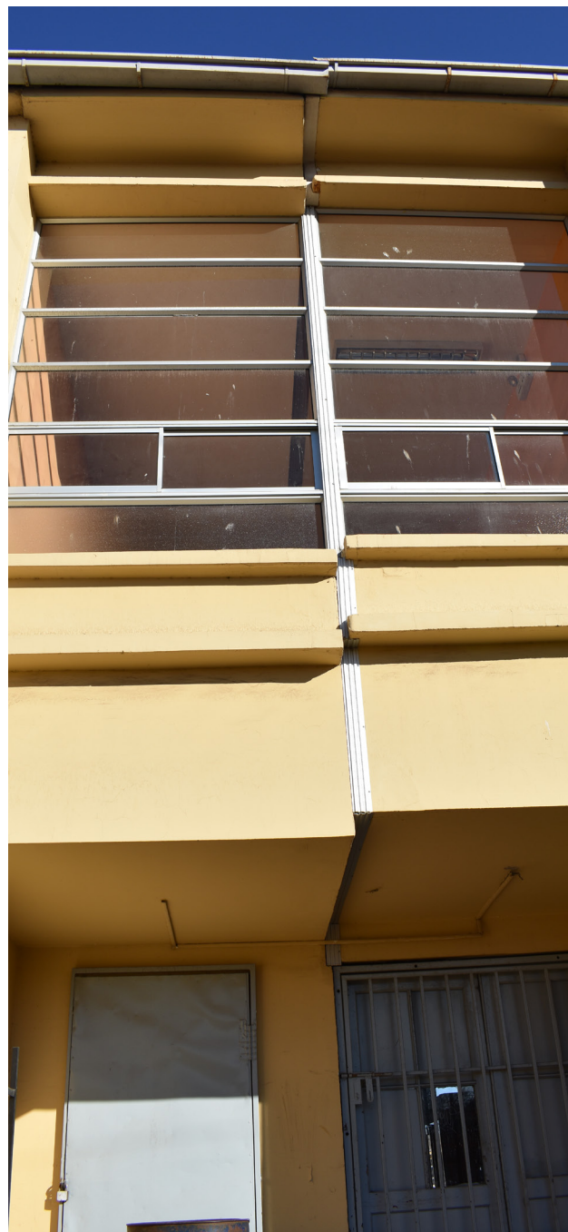
Imagen 11: Junta de dilatación en Liceo Dante Parraguez Fuente: Archivo FONDECYT
