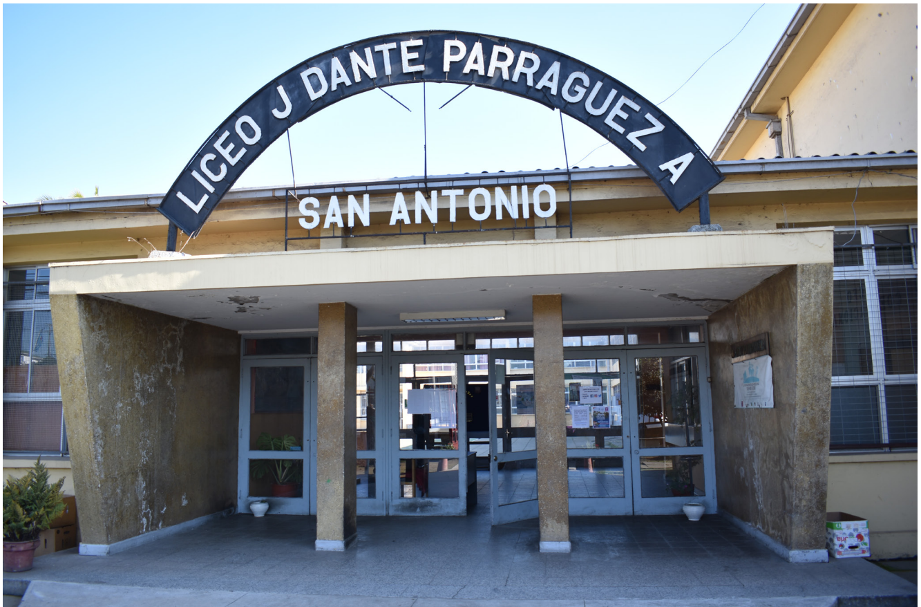
Imágenes 81: Vista del acceso principal
