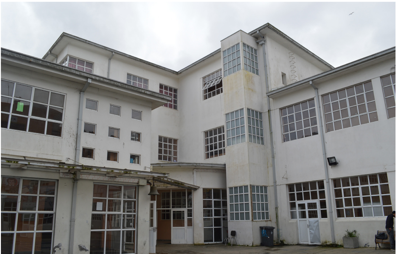
Imágenes 103: Vista del acceso principal
