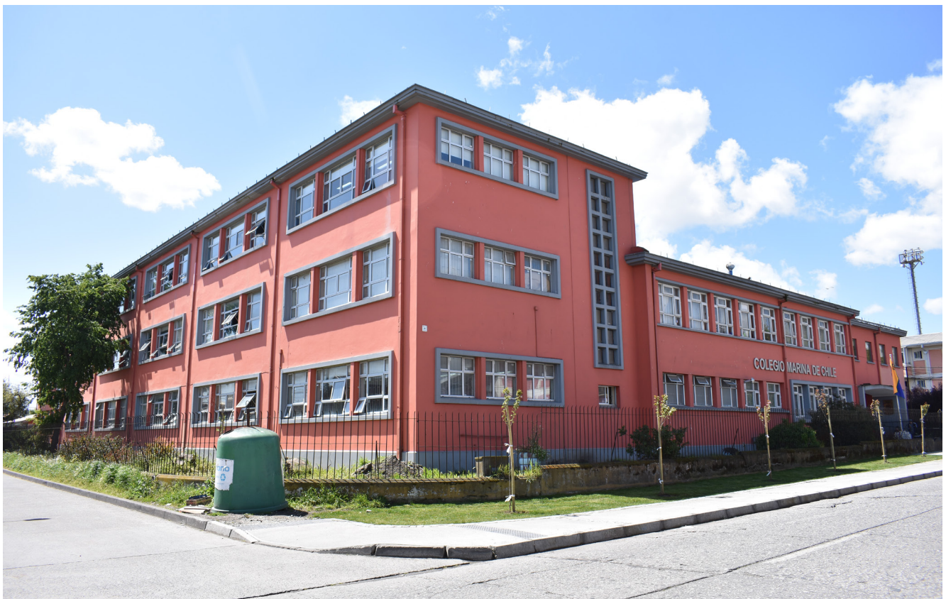
Imágenes 118: Vista del acceso principal
