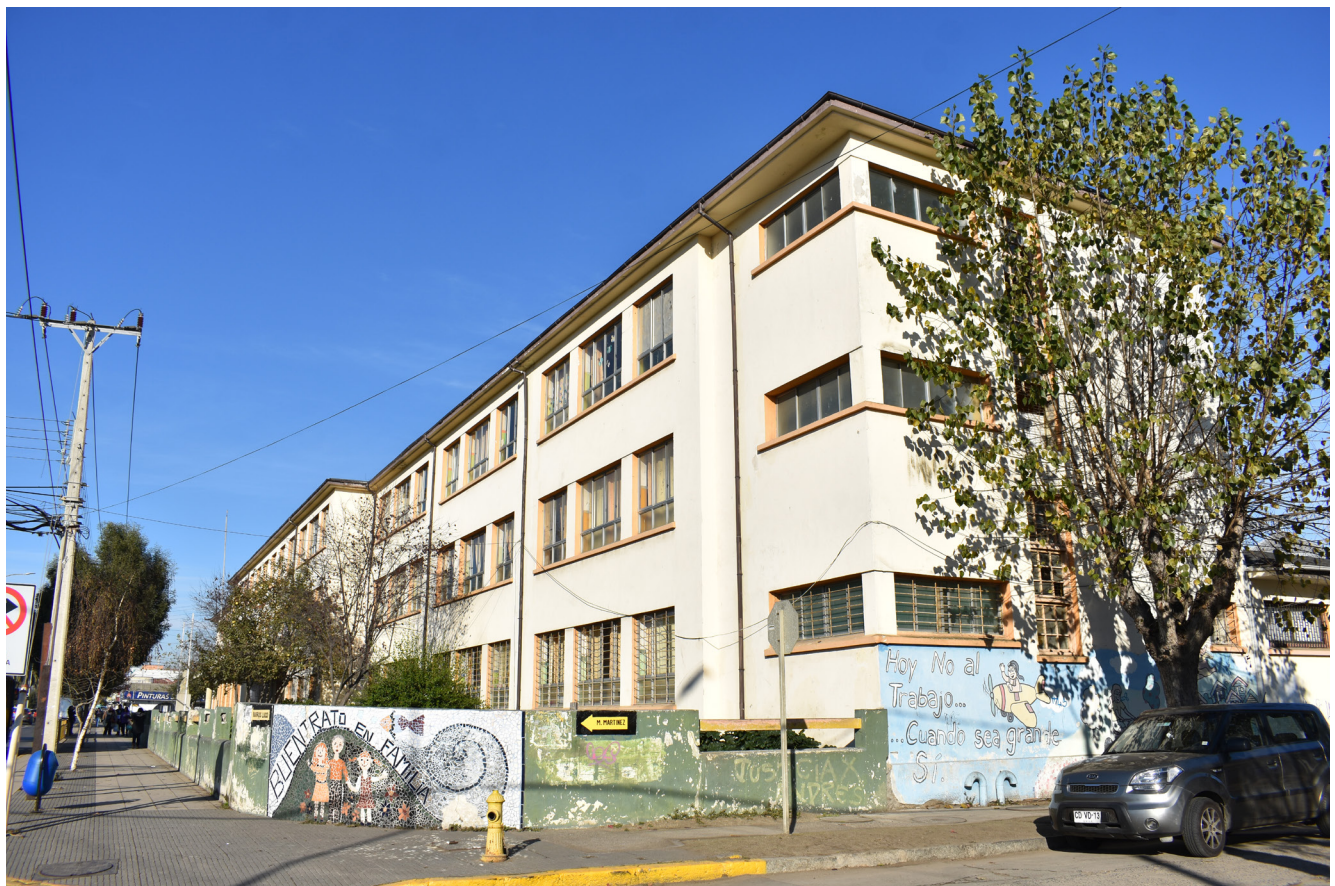
Imagen 44 : Vista exterior del Grupo Escolar Barrancas
