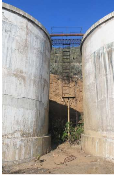
Fig.53. Depósitos de cal. Fuente: Jorge Delgado.
