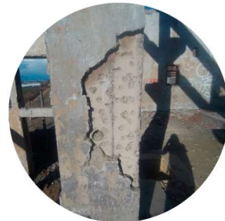
(4) DESPRENDIMIENTO DE REVOQUE
