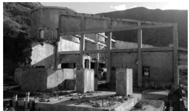
Fig.43 Instalaciones desmanteladas (2018). Fuente: Archivo personal.
