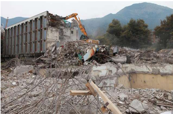
Fig.23. Demolición del edificio CIMM (2013). Fuente: mch.cl
