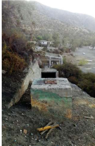
Fig.57. Cimientos y túnel de correas transportadoras. Fuente: Archivo personal.
