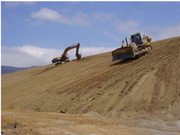
Fig.30. Estabilización de taludes y recubrimiento con arcillas. Segunda etapa, Lo Aguirre. Fuente: SMP, 2010.
