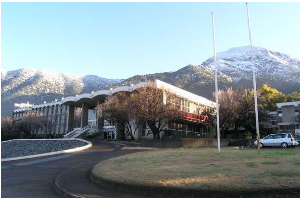
Fig.22. Edificio CIMM antes de la demolición (2013). Fuente: nuevamineria.com
