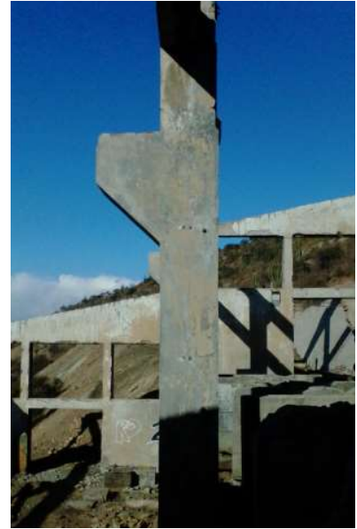
Fig.54. Pilar H.A. con ménsula de apoyo. Fuente: Archivo personal
