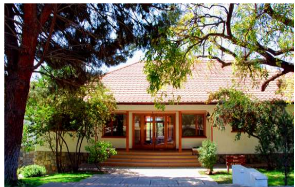
Fig.45. Casino reconvertido en Centro de eventos. Fuente: www.portalinmobiliario.com
