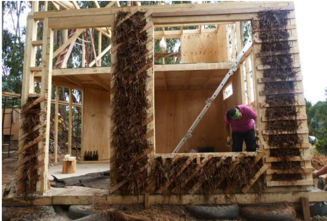
Fig. 45 Proceso constructivo, Quincha en madera. Fotografía extraída de naceunasemilla.com/cursos-bioconstrucción/
