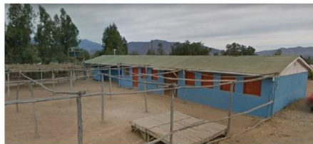
Coperativa comunidad de roco.
