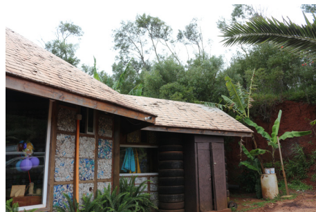
Oficinas de la planta de reciclaje. Cubierta hecha con cajas de Tetrapak Fuente: Elaboración propia
