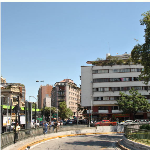
Figura 11 Transito de peatones interrumpido por autopista
