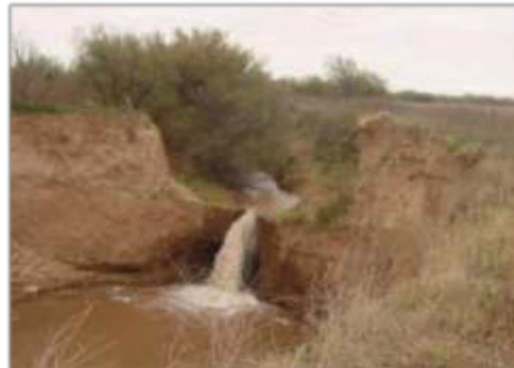
Figura 1.7 Muestra de erosión en fondos de ríos
