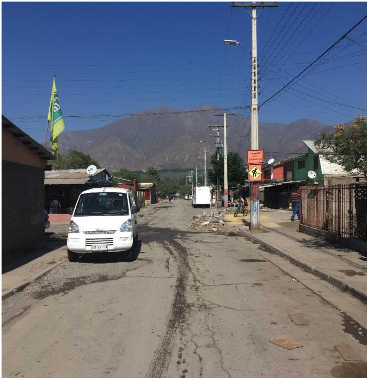
Fotografía 4: Límite interior entre la Villa 250 Años y la Villa Industrial. Se aprecia mala calidad del pavimento en la calle y veredas
