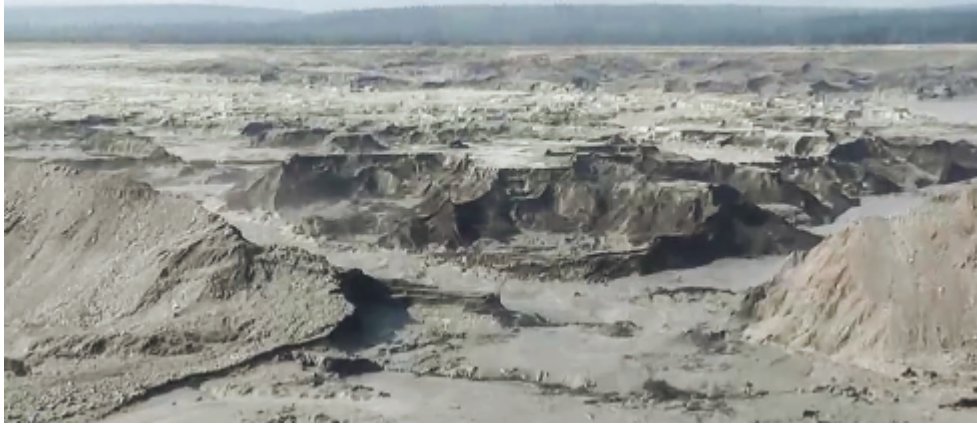
Figura 4.15: Vista frontal del colapso del depósito de relave de Mount Polley ocurrido en Agosto de 2014. Fuente: Morgenstern et al. (2015).
