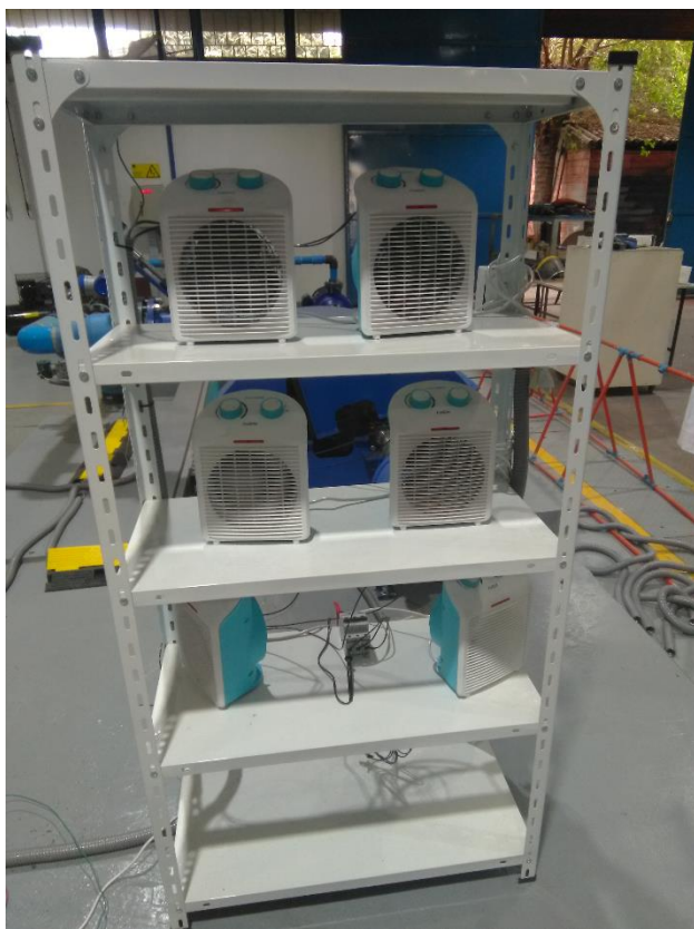
Figura H.26: Repisa con 6 estufas utilizadas como resistencias que requieren potencia eléctrica de la microcentral.
