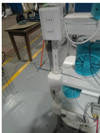
Figura H.27: Interruptores monofásicos para conectar las estufas en pares a cada fase del generador.
