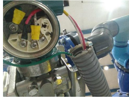
Figura H.16: Conexión de tubo de pitot de microcentral hidráulica.
