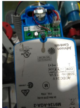
Figura H.9: Tapa de válvula de seguridad M9124-AGA-2.
