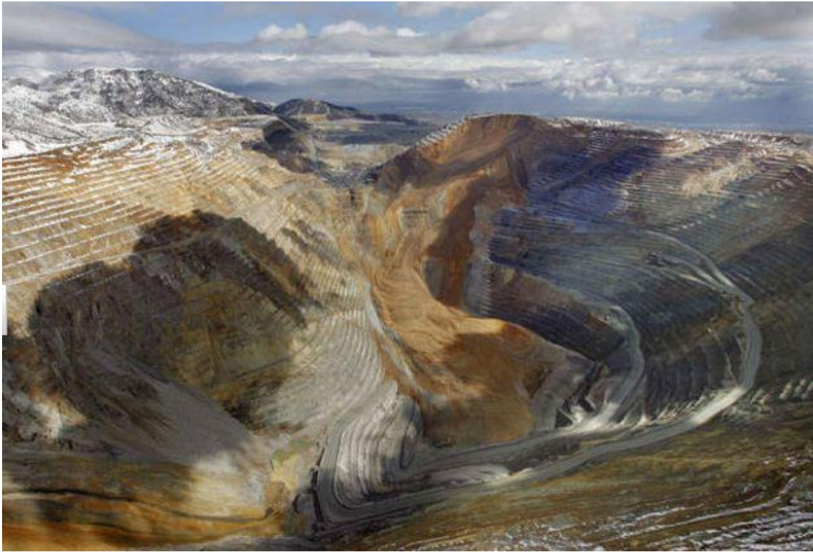
Figura 43. Falla ocurrida en la pared noreste de Bingham Canyon el año 2013 (Llano-Serna et al, 2016).
