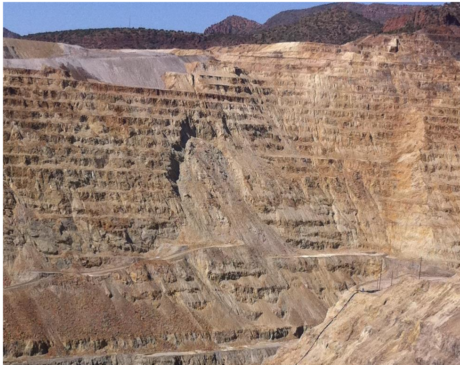
Figura 26. Deslizamiento en el sector norte del rajo Pinto Valley producto de fallas geológicas presentes en la pared (foto tomada por el autor, 2012).
