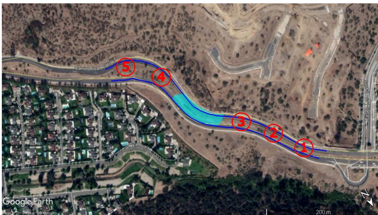
Figura 24. Trayecto de afloramientos observados al costado de la calle Camino Juan Pablo II en la zona de falla occidental en Lo Barnechea, y que se utilizaron para la elaboración de fotomosaicos (línea azul). Los números de 1 a 5 indican el número y ubicación del fotomosaico, tanto para el fotomosaico estructural como geotécnico (Figuras 34 y 18). El área celeste representa la parte de los afloramientos que no se consideraron dentro de los fotomosaicos de las Figuras 34 y 18 para facilitar la vista de esta zona, ya que correspondían a andesitas relativamente competentes en la calle de arriba (parte de las cuales se incluyen en los fotomosaicos 3 y 4) y aparentemente a las mismas rocas, pero cubiertas con “shotcrete” en la calle de abajo. Imagen tomada de Google Earth Pro.
