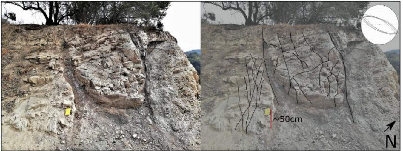
Figura 22. Distribución de fracturas en el macizo al final de la calle El Golf de Manquehue.
