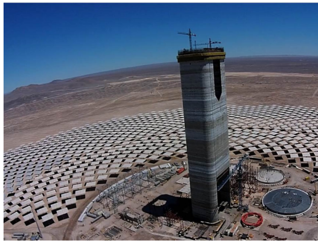
Figura 1.5: Imagen de la planta termosolar en construcción [7]
