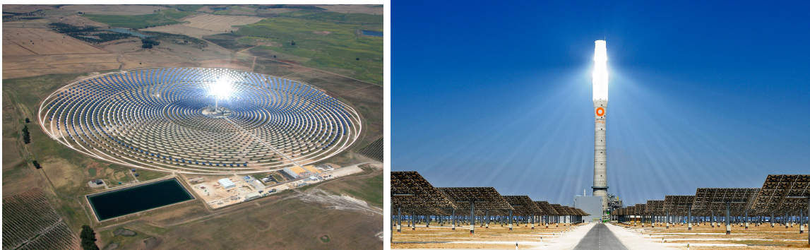
(a) Campo de helióstatos planta Gemasolar (b) Torre central plataforma solar Gemasolar
