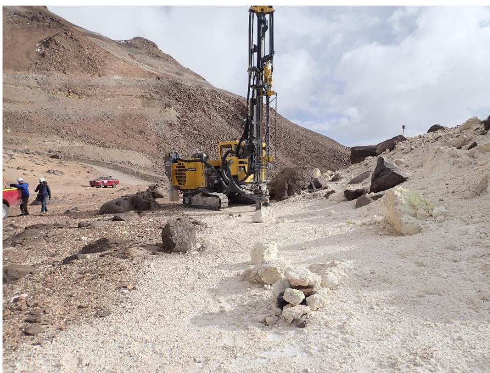
Fotografía 12. Perforación en pumita blanca punto B3. DM 2+500
