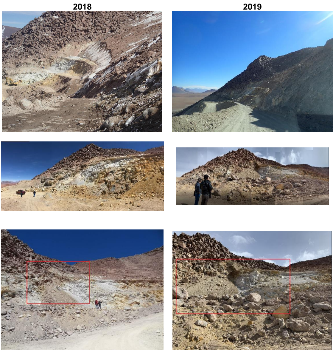
Figura 22. Reconocimiento de problemas de estabilidad en el kilómetro 3.70 del camino de acceso. Todas las imágenes ubicadas en la izquierda fueron tomadas el 2018, las imágenes de la derecha en el 2019. (Fotografías adaptadas de Yoshikawa, 2018-2019)
