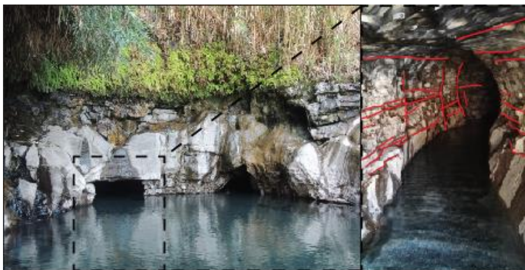
Figura 6-4: Cocha Resbaladero, manantial termal de uso balneológico. Se observan fracturas horizontales y verticales por donde infiltra el agua. La surgencia principal se encuentra en el suelo al interior del socavón (a la derecha).
