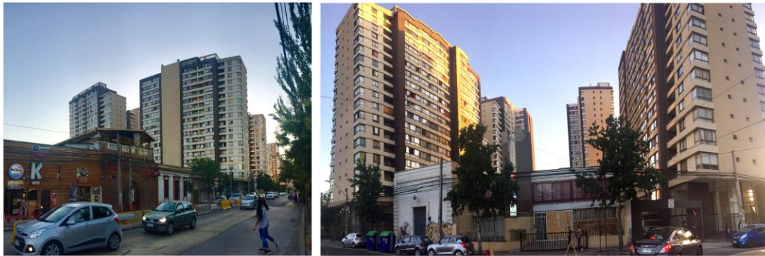
Figura 8: Registro fotográfico unidad de análisis de la comuna de Independencia. Fuente: Elaboración propia.
