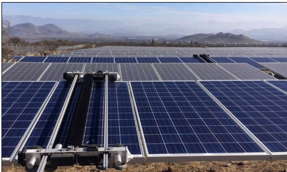
Figura 14-6 Funcionamiento del robot en terreno
