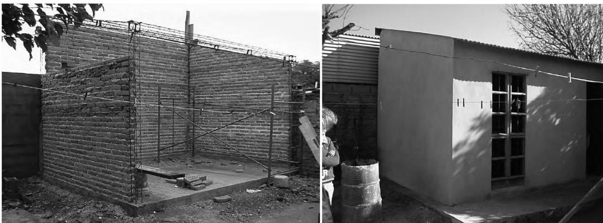
Figura 47: Auto-construcción utilizando ladrillos y placas de ladrillos con plástico reciclado (Gaggino, 2008).
