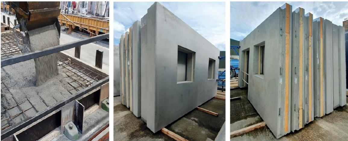
Figura 48: Hormigonado de elementos sándwich con una base de RCD y productos finales (fábrica de hormigón Creagh) (PHI, 2020).
