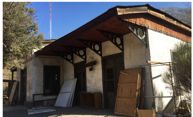
Est. San José: En una primera instancia biblioteca, luego Salón cultural y actualmente como bodega.
