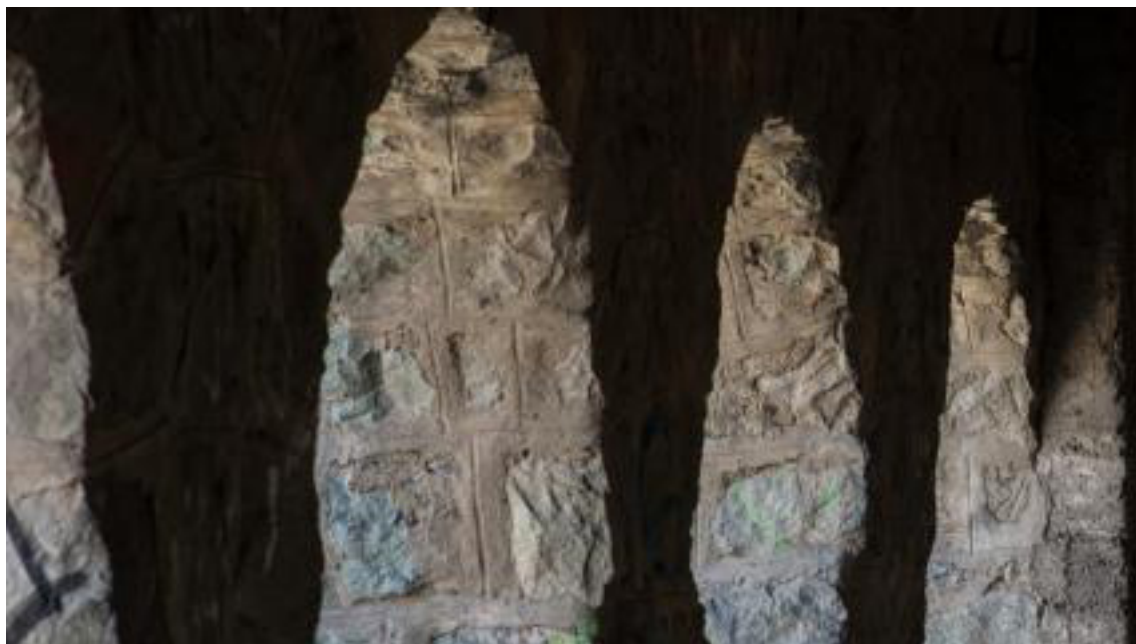
Interior del túnel El Tinoco
