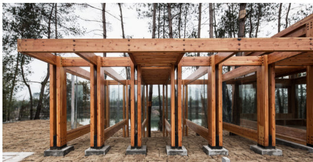
Pabellón Parque de Pinos, Lishui, China. Arq: DnA
