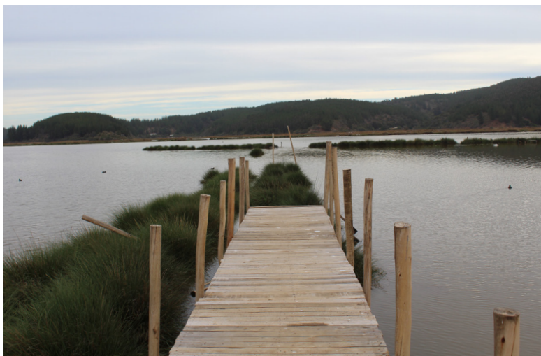
Fig. 61: Pasarela de Barrancas. Fuente: Colección Propia. (2019)
