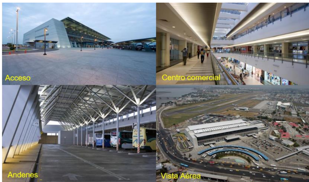
Imagen 4: Terminal Terrestre de Guayaquil.
