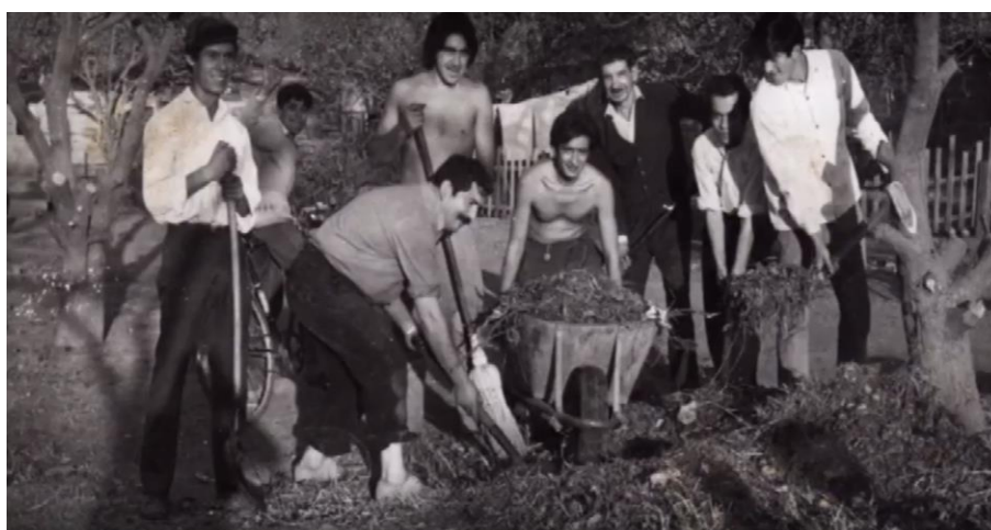
Foto: Pobladores de Millalemu en faenas de autoconstrucción Fuente: MINVU 2016b
