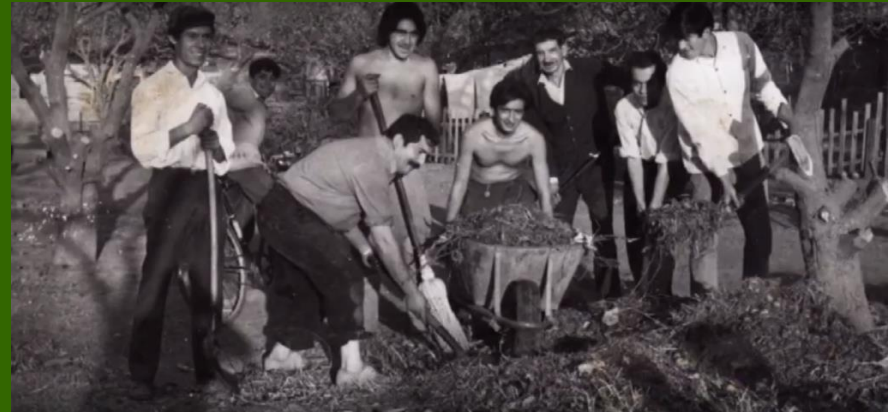
Foto: Pobladores de Millalemu en faenas de autoconstrucción Fuente: MINVU 2016b
