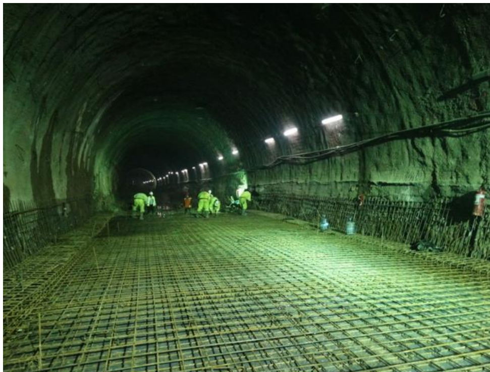
Figura 3-7: Túnel interestación tipo Herradura en la Grava del Mapocho, Línea 3 del Metro de Santiago (Pozo J.C., 2019).
