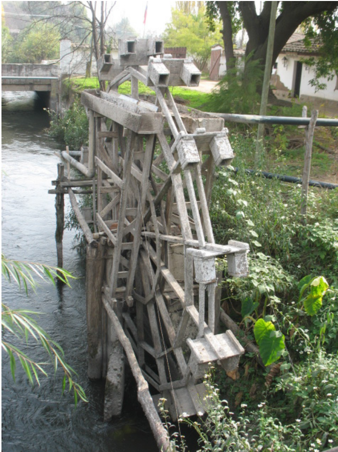
Figura. N°16. Azuda con capachos de madera con el diseño tradicional de las primeras ruedas de agua de Larmahue. IHP. 2012.
