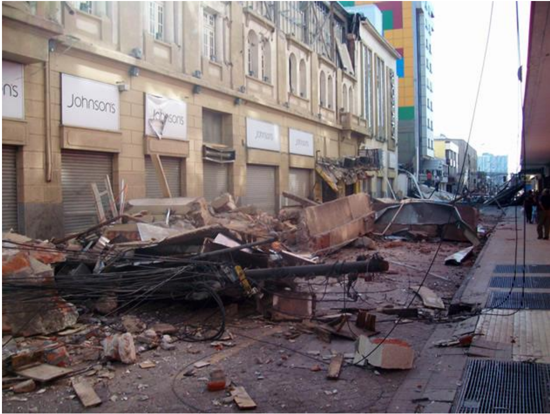
Fig. 5.26 Daños frontis tiendas Johnson calle Colo-Colo, perpendicular a N60°E (Foto propia).
