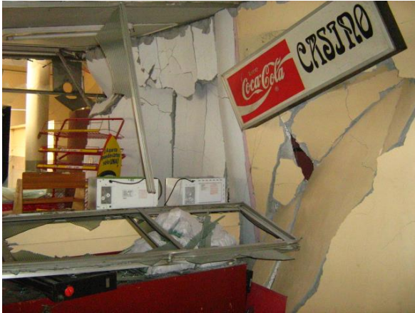
Fig. 2.23 Panel existente cercano al Eje3, vista desde el interior.
