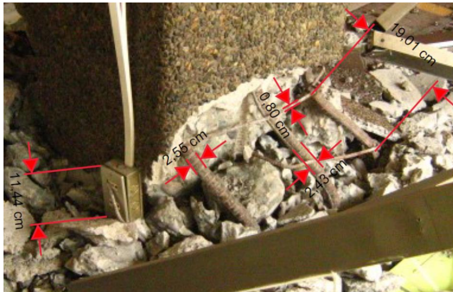
Fig. 2.29 Diámetros de las armaduras de refuerzo.
