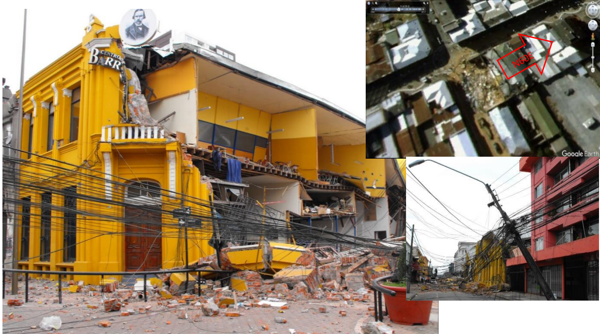
Fig. 5.30 Daños en Centro de formación técnica Barros Arana (Fotos Eduardo Muñoz).
