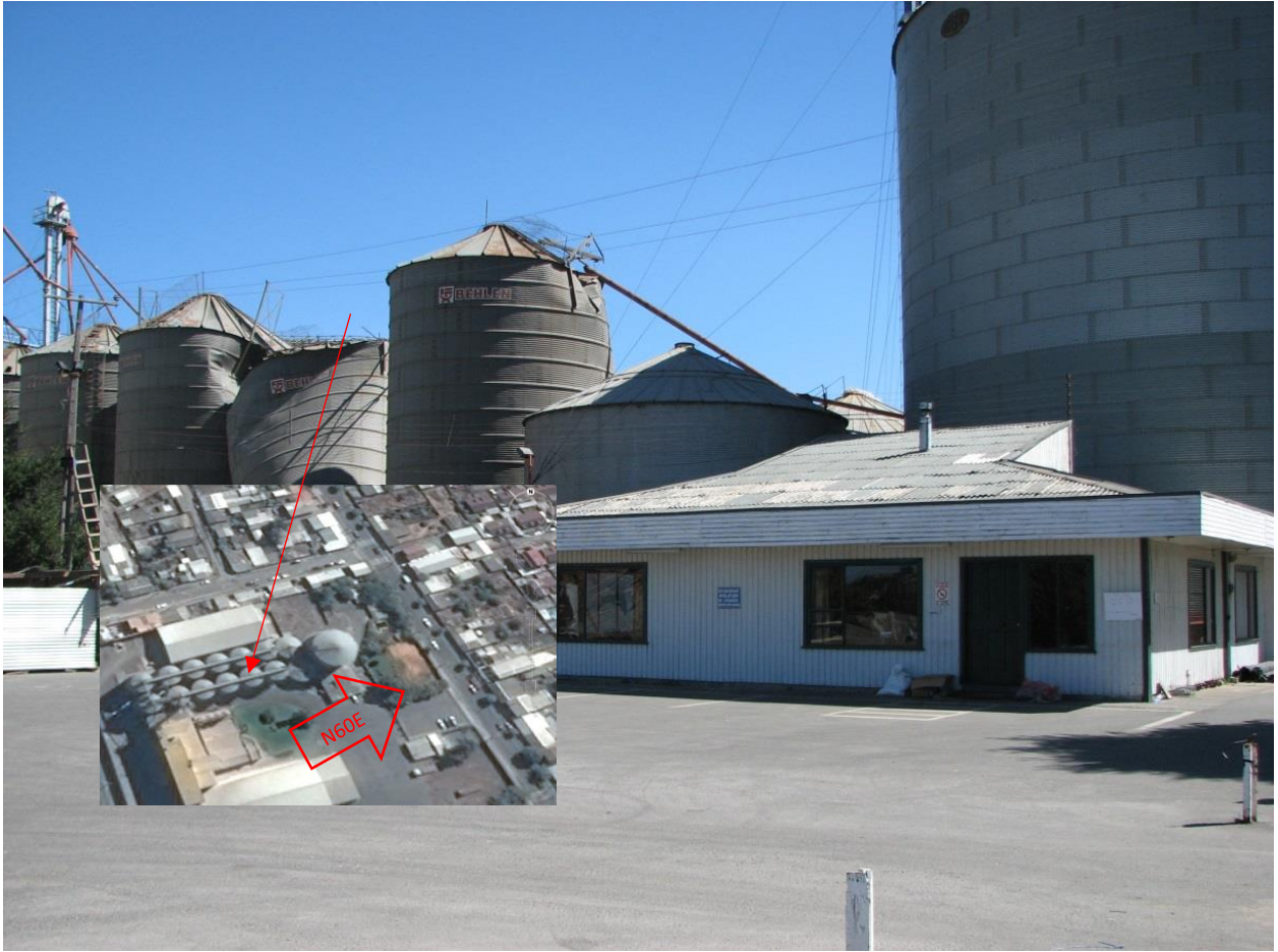
Fig. 5.55 Daños en Silos de almacenaje en la ciudad de Coronel (Foto propia).
