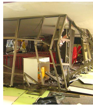
Fig. 2.28 Concentración de columnas cercanas al Eje 1-B, vista desde el Sur.
