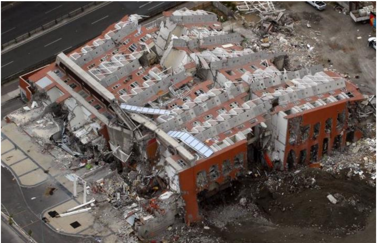
Fig. 4.10 Colapso de edificio “Alto Río”.
