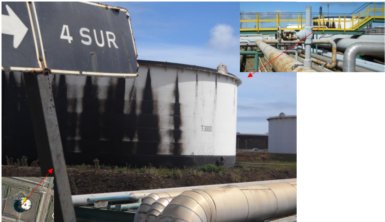
Fig. 5.50 Derrame en estanque T-3000 (Foto Carlos Patuelli)
