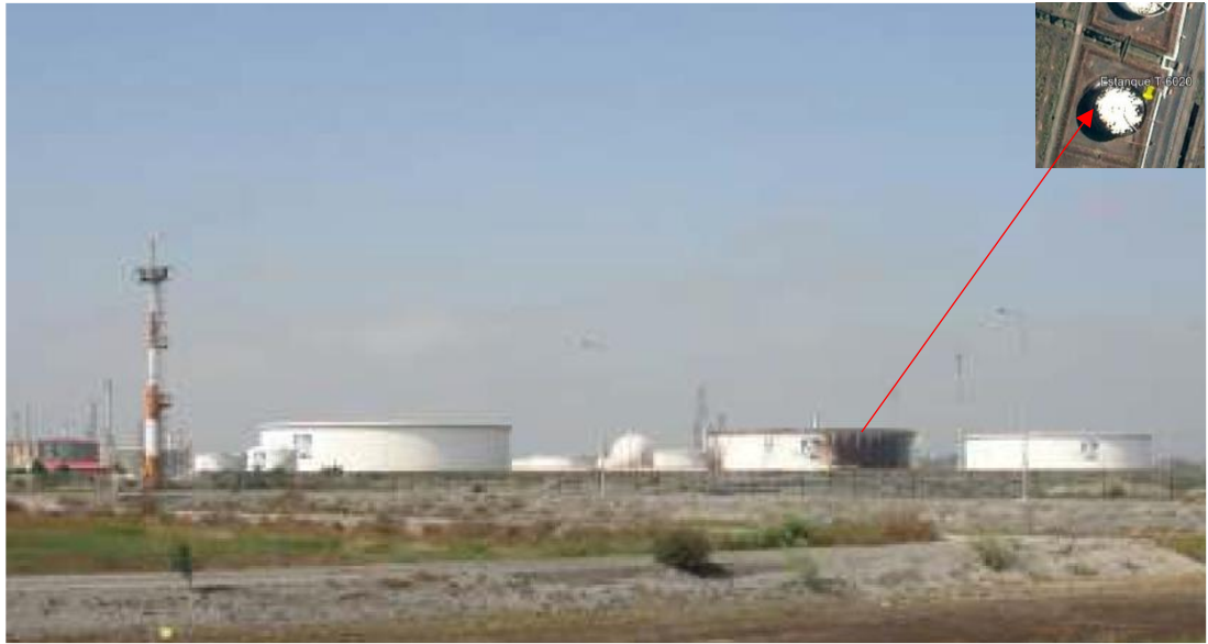
Fig. 5.49 Derrame en estanque T-6020 [63].
