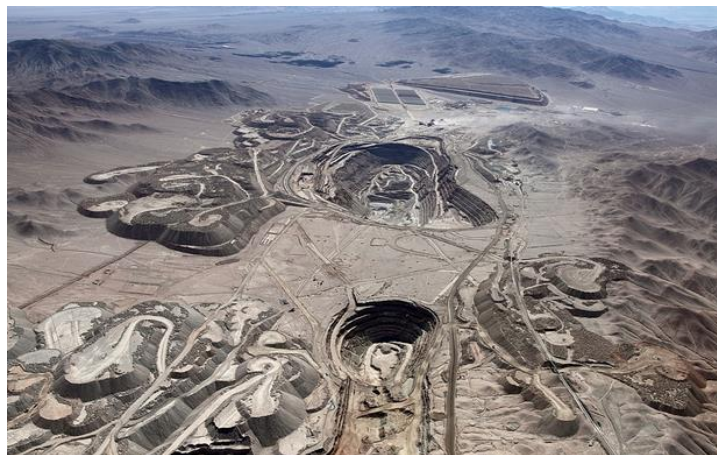
Figura B.7 Vista General de la Operación, Radomiro Tomic Fase II
