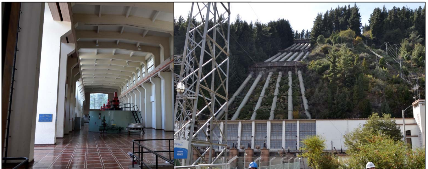
Figura 1.1 – Vista interior (izq.) y exterior (der.) Central Abanico (fuente: autor).
