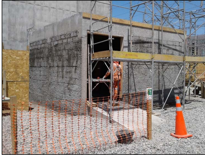
Figura 3.2 – Construcción sala eléctrica. Albañilería confinada (fuente: autor).
