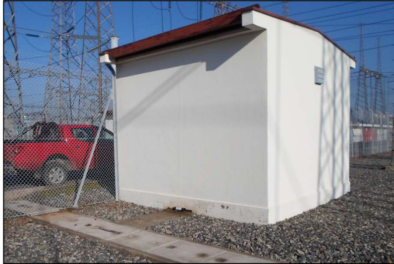
Figura 1.2 – Caseta eléctrica (albañilería), subestación Alto Jahuel (fuente: autor).
