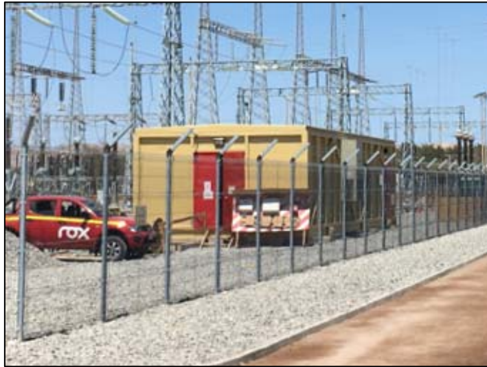
Figura 3.4 – Sala prefabricada en terreno. Estructura en acero (fuente: autor).
