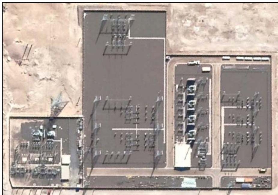
Figura 3.1 – Vista aérea Subestación Eléctrica Calama (fuente: Google Earth).
