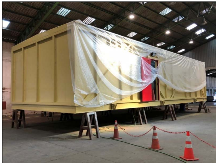
Figura 3.3 – Ejemplo construcción en taller de sala prefabricada. Estructura en acero (fuente: autor).
