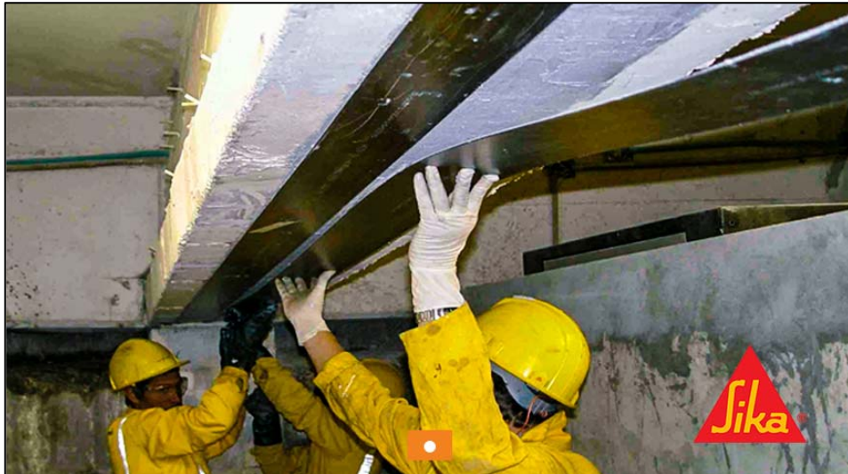
Figura 2.1 – Utilización de láminas de CFPR [23].
