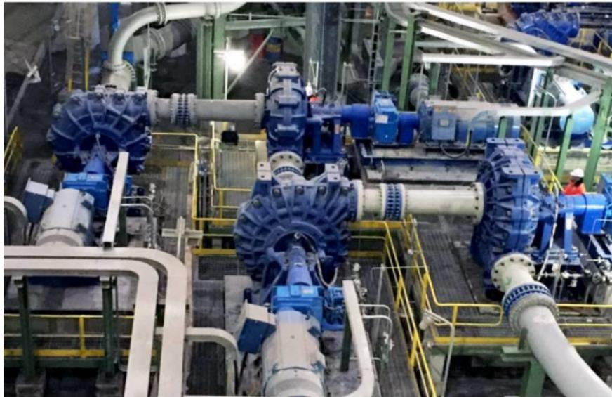
Figura 1.2: Ejemplo de un tren de 4 bombas centrífugas en serie.
