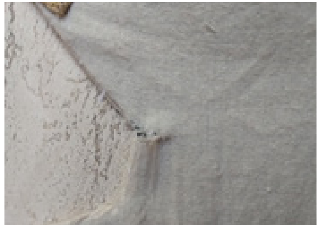
86. Resultado fisuras en textil prueba 4.
