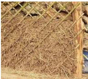
Muestras de diferentes tipos de paneles o muros hechos con sistema de quincha
