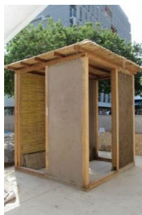
Muestras de diferentes tipos de paneles o muros hechos con sistema de quincha
