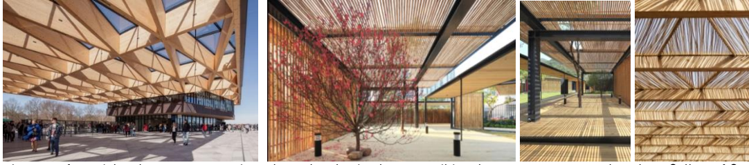
Imágenes referenciales de estructura en vigas de madera laminada para recibir sub-estructura para sombreadero. Gallery of Community Green Station / Hong Kong Architectural (Smith, 2020).
