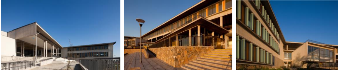
Fotos Obra Scuola Italiana, Las Condes, Chile (Proyectos, 2008).
