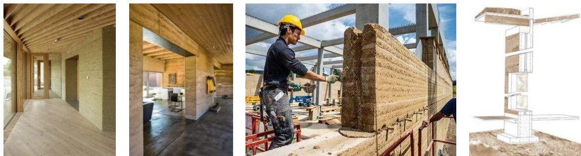
Fotos referenciales del tipo constructivo de abobe apisonado y estructura de hormigón armado (Smith, 2020).
