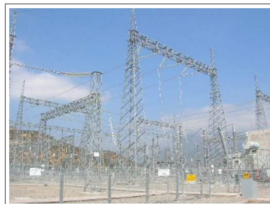
Figura 2.30: Marco Barra 500 kV
