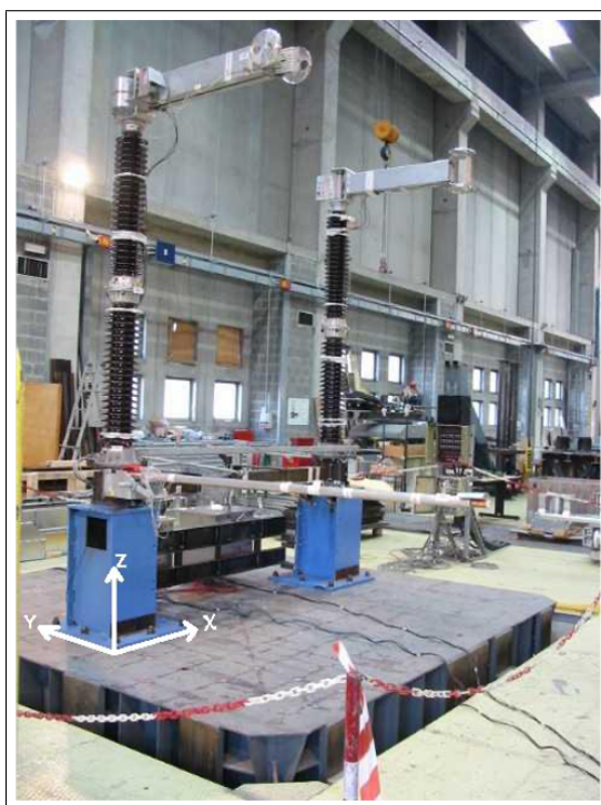
Figura 2.95: Desconectador montado sobre mesa vibratoria [35].
