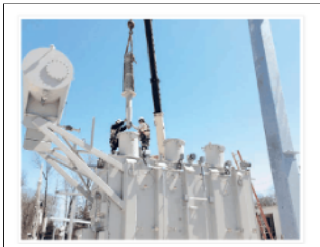
Figura 2.50: Bushing 220 kV [28].
