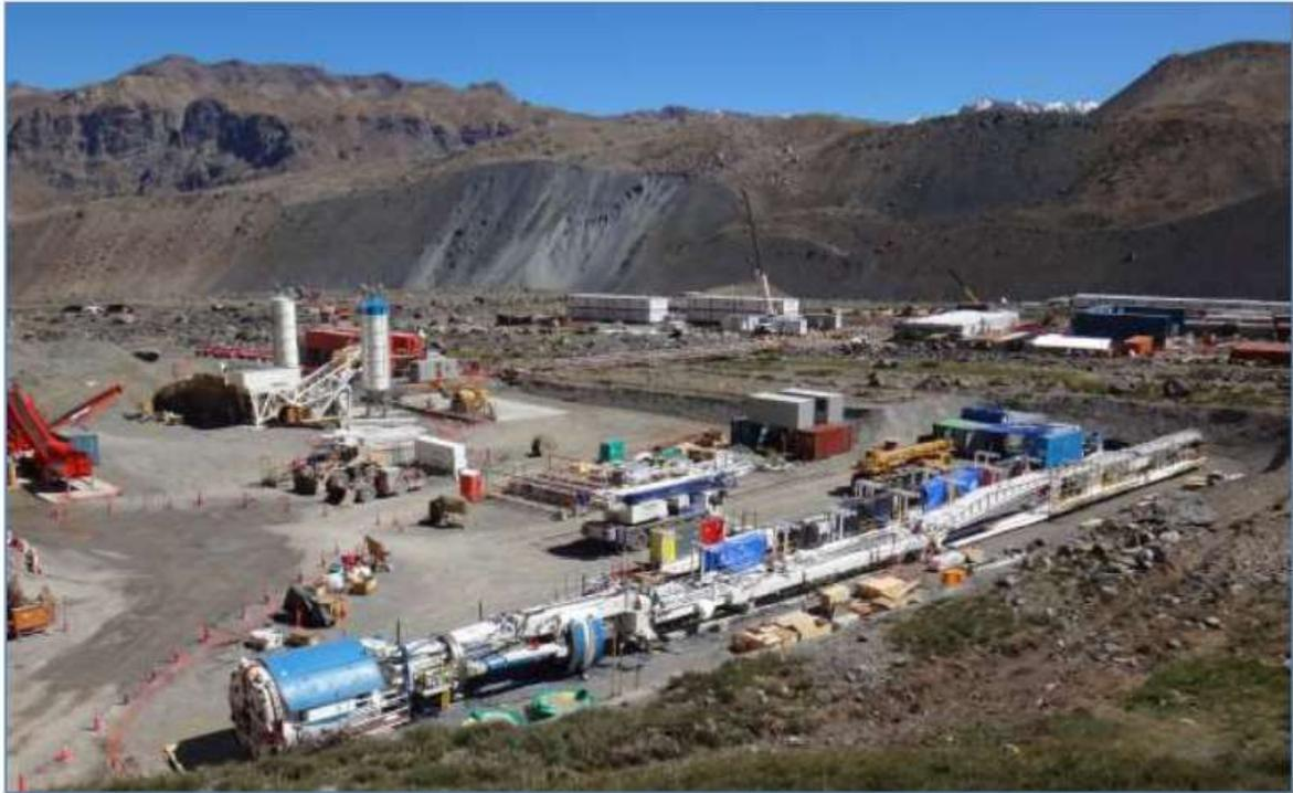
*Figura 2.26: Sitio de montaje de la TBM Proyecto Hidroeléctrico Alto Maipo (Robbins, 2020).*
