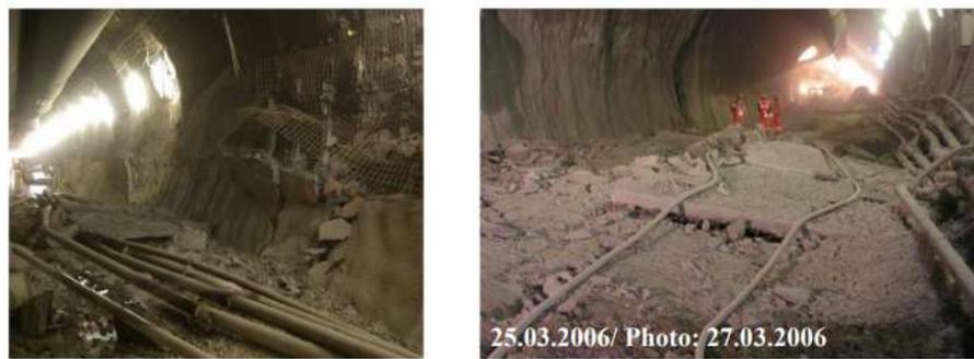
**Figura 2.15:** Daños generados en el túnel de excavación producto de eventos de estallido de roca en el Túnel Base San Gotardo (Rehbock-Sander & Jesel, 2018).
