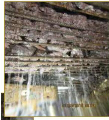
*Figura 2.13: Ingreso de agua en el Túnel El Volcán de Alto Maipo (Robbins, 2020).*
