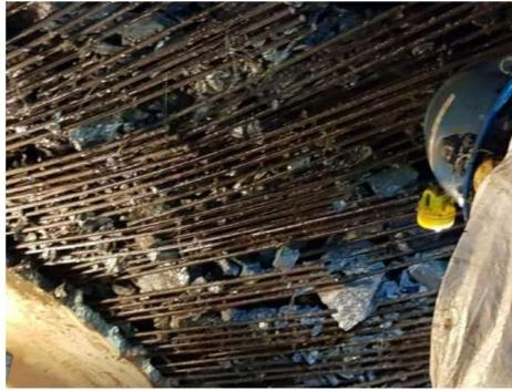
**Figura 2.14:** Roca altamente fracturada encontrada en el Túnel El Volcán de Alto Maipo (Robbins, 2020).
