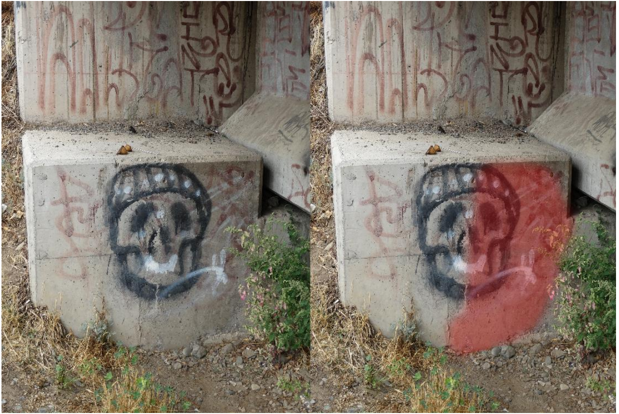
Figura 6.10: Reparación de Estribo 2 Puesto Águila Norte.
