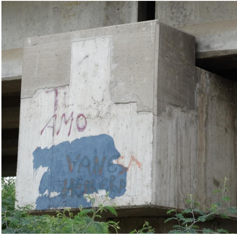
Figura 6.11: Reparación de Tope Exterior Sur Cepa 2 Puente Águila Norte.
