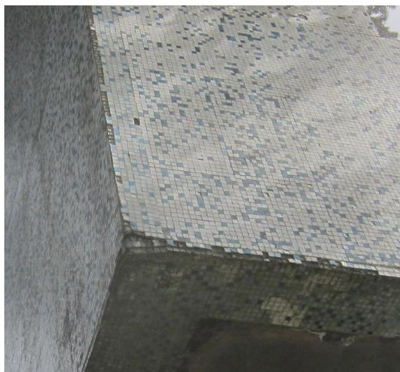
Figura 162. Detalle de esquina con desprendimiento de teselas.
