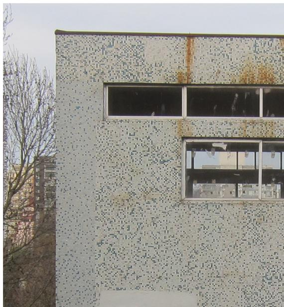
Figura 159. Elevación poniente, con teselas originales y alternativas.
