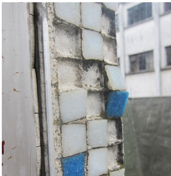
Figura 161. Detalle de ventana con desprendimiento de teselas.
