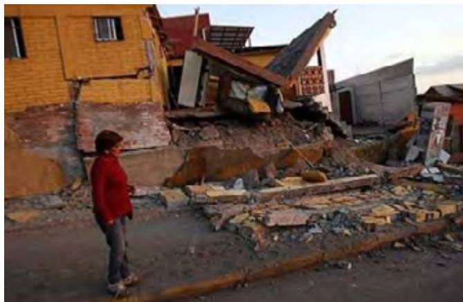
Imagen daños terremoto en ciudad de Iquique. Extraída el 19.08.2019 desde: http://www.elboyaldia.cl/noticia/sociedad/delegado-presidencial-un-ano-del-terremoto-de-iquique
