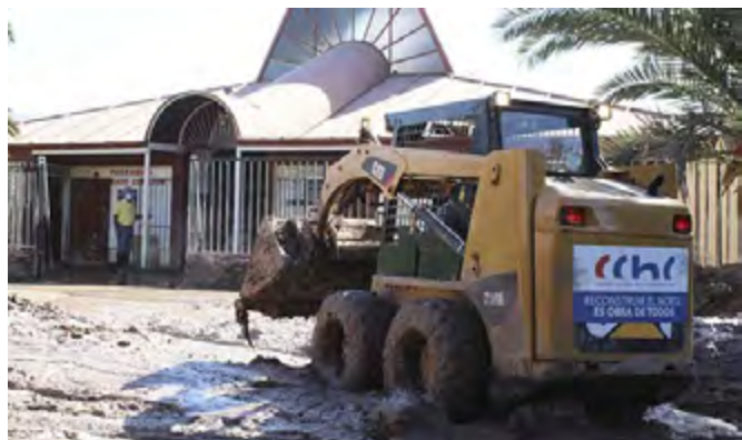
Foto Limpieza de Calles: Extraída el 03 de junio de 2019 desde http://lanoticiainline.cl/social/cchc-despeja-29km-de-calles-en-copiapo-afectadas-por-el-aluvion/
