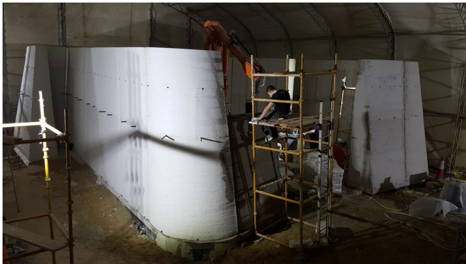
Figura 4.2: Proceso de impresión del Laboratory for Drones en el SOLar Park de Seih Al-Dahal, Dubai - Fuente: https://cybe.eu/cases/rdrone-lab/
