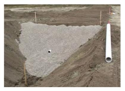
Figura 17. Construcción de un dren con sección trapezoidal (FEMA, 2011).
