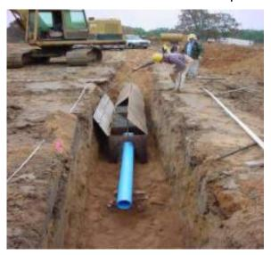
Figura 18. Construcción de un dren con sección rectangular (FEMA, 2011).
