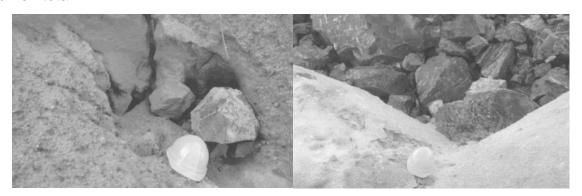
Figura 20. Tubificación de la arena en el enrocado. a) Contacto entre el enrocado y el filtro de arena, b) Partículas de arena migrando al enrocado por escorrentía superficial (Vick, 1996).
