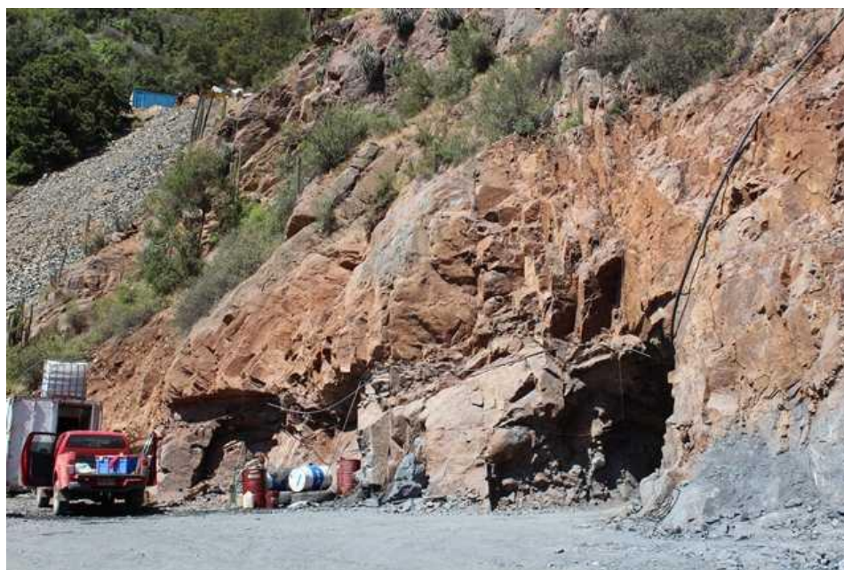
Figura 23. Fotografía de la entrada principal del acceso a Mina Rafaela.
