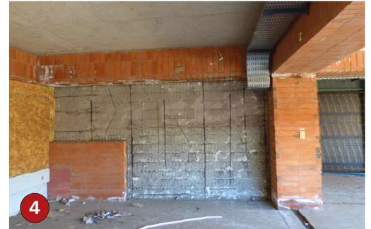
4 Revestimiento tipo albañilería desprendido durante el tsunami, la parte que quedó en pie corresponde al muro original, lo desprendido fue un cierre que se hizo posteriormente.
