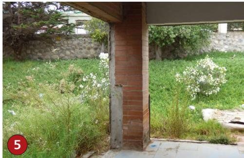
5 Revestimiento tipo albañilería que se dañó durante el tsunami, esto también muestra la verdadera estructura de hormigón del inmueble.
