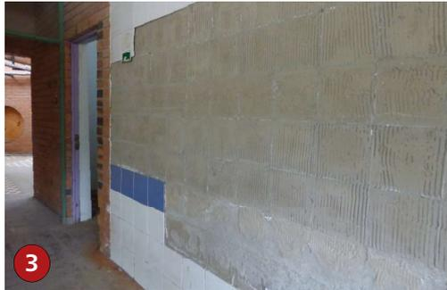
3 Revestimiento de cerámica que se dañó durante el tsunami en el tanque terapéutico.
