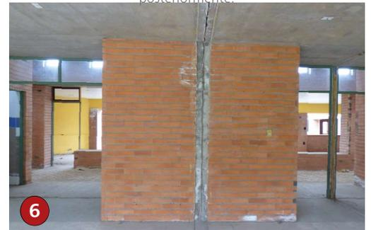
6 Una de las mayores grietas que se pueden ver, sin embargo, corresponde a una junta de dilatación que pasa por el muro, por lo que no supone un daño estructural severo.
