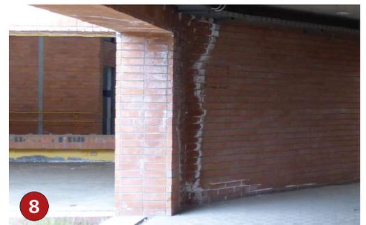
8 Marcas de agua en un muro interior, blancas debido a la salinidad del agua.
