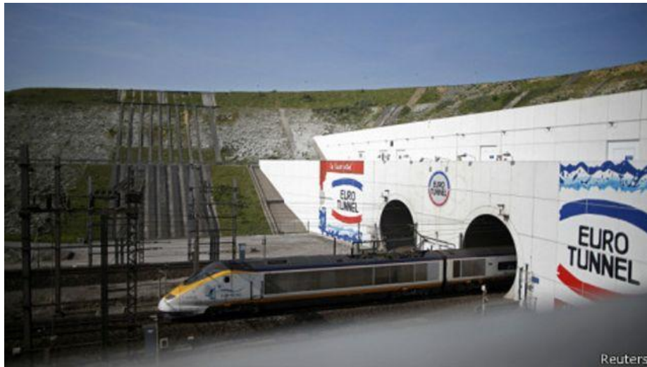
Figura 2: Túnel perforado bajo el canal de la Mancha.
