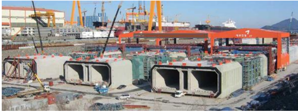
Figura 33: Etapa de construcción - Fabricación de módulos. Túnel Busan-Geoje, Corea.
