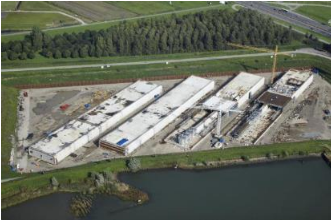
Figura 79: Patio de fundición Barendrecht.
