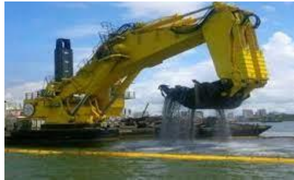
(b) Foto de proceso de dragado. Puerto Manta, Ecuador.
