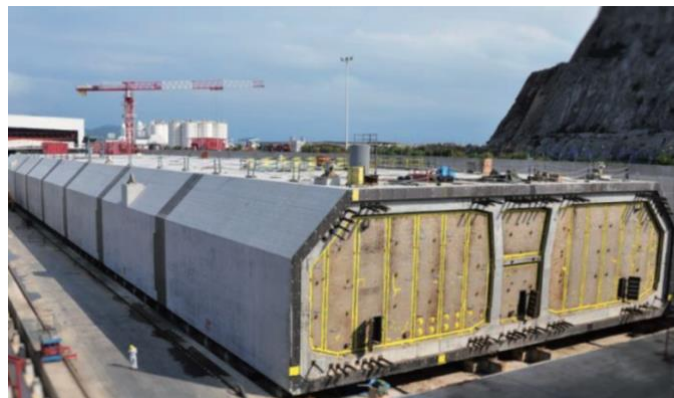
Figura 31: Foto de la junta de inmersión de elemento de túnel en proyecto HZMB Island-tunnel, China. Cuenta con goma de junta Gina y barras para su conexión rígida. Cara del elemento sellada para su inmersión.
