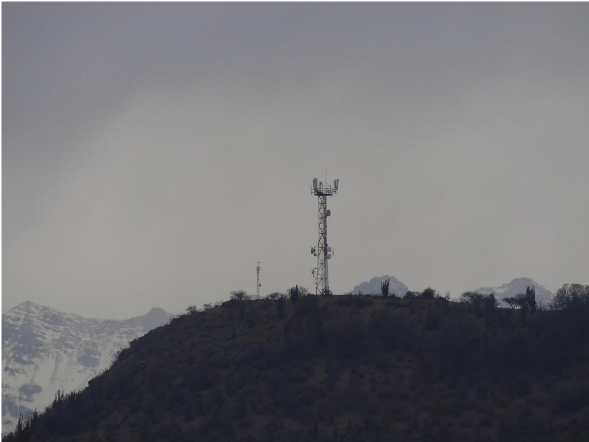
Figura 12. Vista hacia el este de la antena de telefonía en Cerro de La Compañía. Por Monserrat Ramírez (2020)
