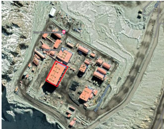
Figura 5.2: Edificio de mantenciones Komatsu - Minera los pelambres
