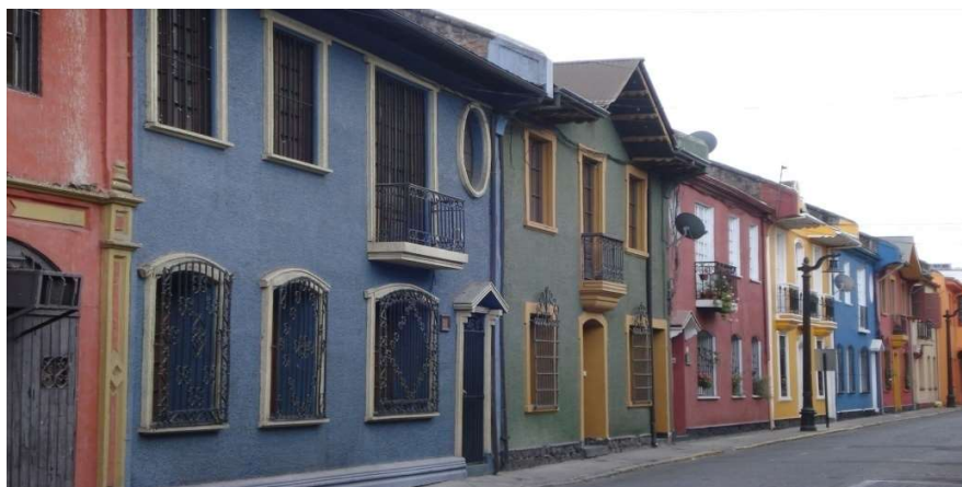
Figura 11. El descolorido de algunas fachadas de Calle Viña del Mar, demuestra la falta de mantenimiento de sus propietarios.
