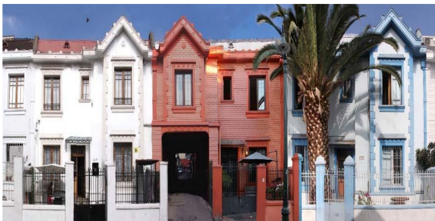
Figura 5. Fachada patrimonial de la zona típica Calle Viña del Mar.
