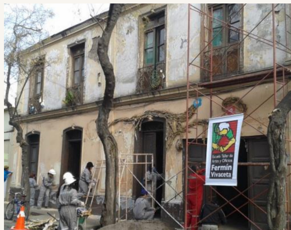
Fuente: Escuela taller de artes y oficios, Fermín Vivaceta, 2014. Restauración fachada
